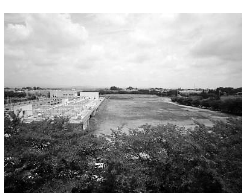
メガソーラー設置箇所
